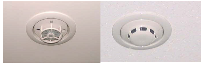
写真7 差動式感知器（左）と煙式感知器（右）
